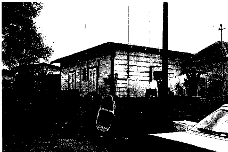
Woningen in de wijk Juana Mateo, die gerenoveerd wordt
