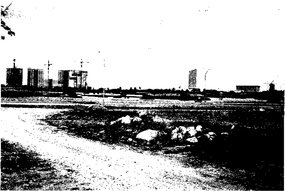
Hotels in aanbouw
